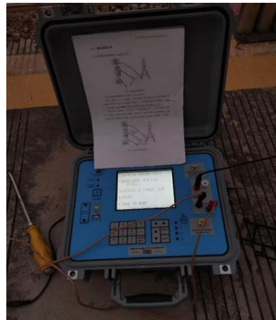
图 A6 试验现场冲击接地电阻测试
